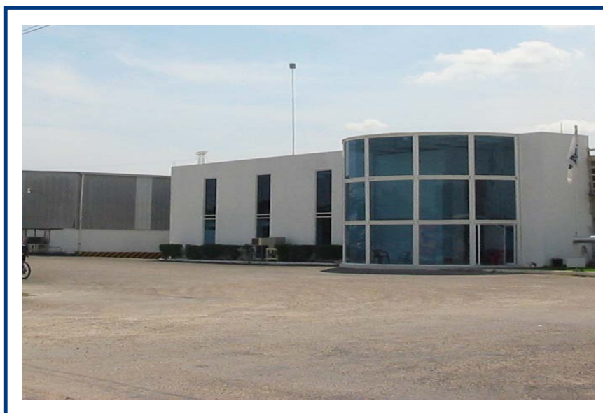
Foto de la fachada de la nueva planta.
